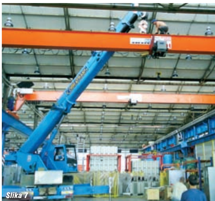
Godine 2006. montirana je 8 tonska dizalica jednogredne izvedbe
